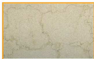
Fleckenmuster durch Verunreinigungen im Dampfcondensat
